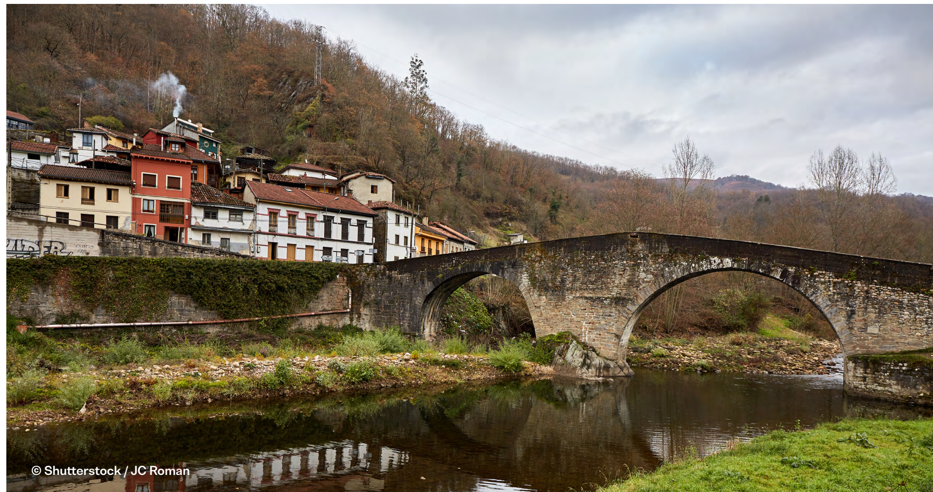
Puente romano de Puente de Arco Roman bridge of Puente de Arco
